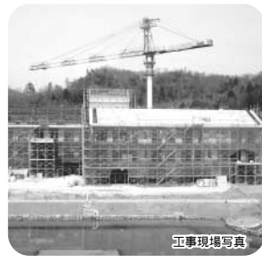
工事現場写真
